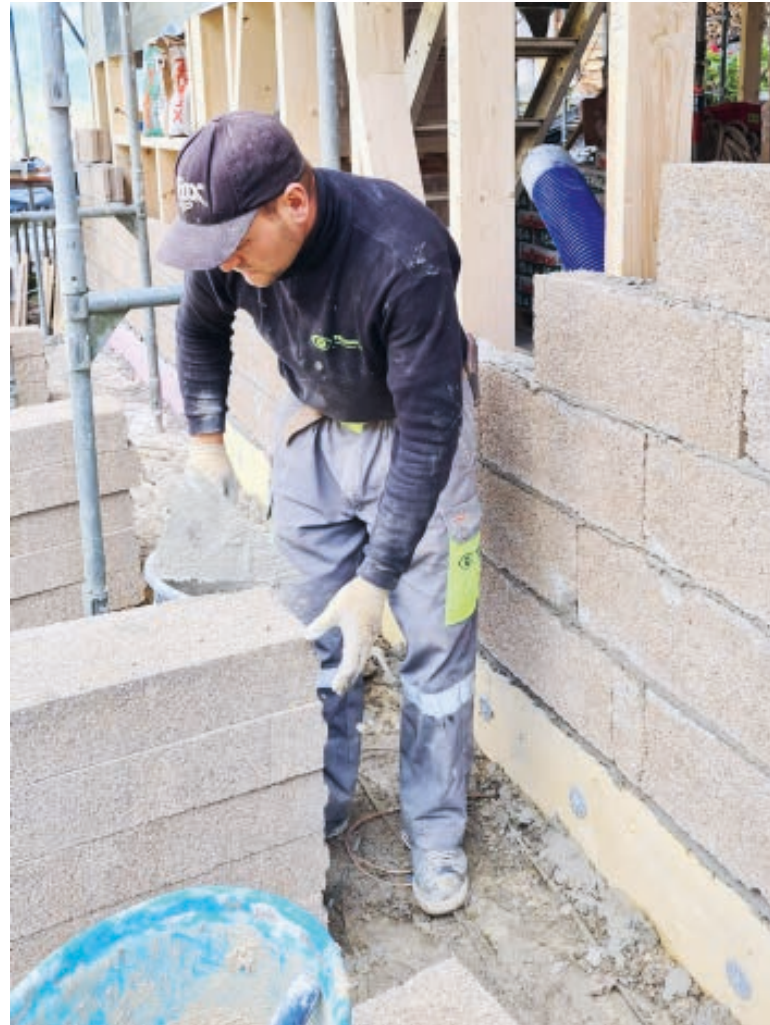
Einbau von Hanfsteinen als Aussenwanddämmung. (Bild: hanfhandwerk.ch)
