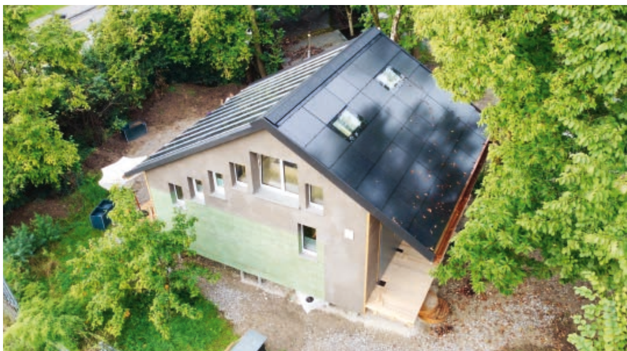
Das Kreis-Haus in Feldbach/ZH, ein Forschungsprojekt der ZHAW, ist mit Hanf gedämmt. (Bild: Devi Bühler)
